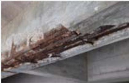
Die Erkennung von Hot Spots, an denen aktive Korrosion einsetzt, umfasst die Messung der georteten Negativwerte des Halbzellenpotentials (d. h. des Korrosionspotentials). Bei der Verwendung einer Stabelektrode muss der Benutzer ein Raster definieren, das ausreicht, um lokale negative Spitzenwerte zu erfassen.
